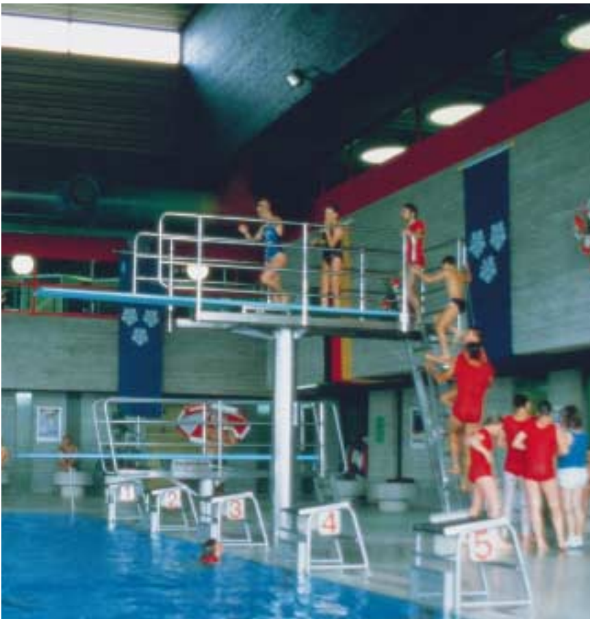
Sicherer Schwimmbadbetrieb: Die gesamte Konstruktion des Sprungturms in einem Hallenbad besteht aus Edelstahl Rostfrei.
