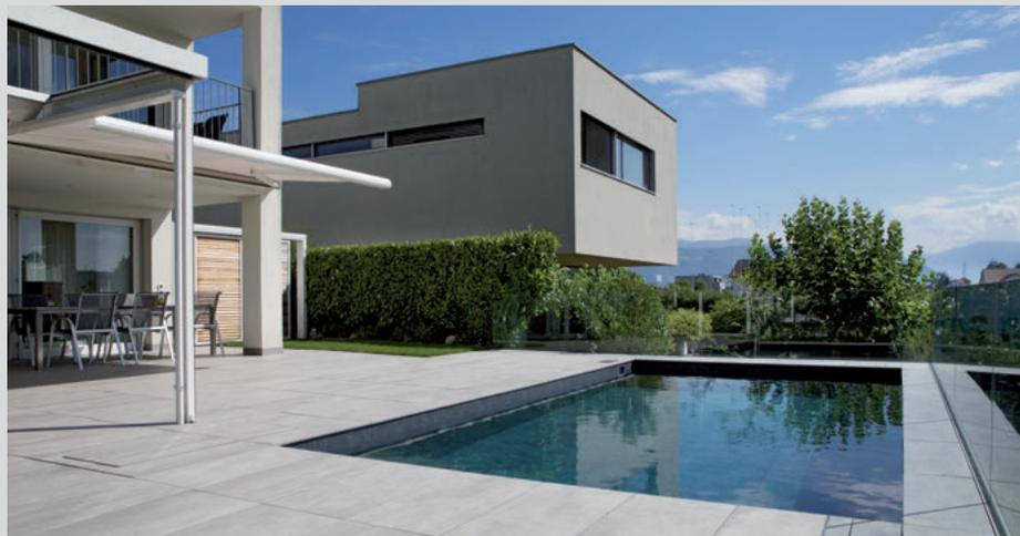
Der «Vitapool Classic» im Format 6,5 x 3,35 m wurde exakt an die umgebenden Platten angepasst, damit diese nicht geschnitten werden mussten und das Fugenbild gleichmässig bleibt. Wegen der Hanglage entschied man sich für eine Stahl-Holz-Konstruktion in Leichtbauweise. Vita Bad AG
